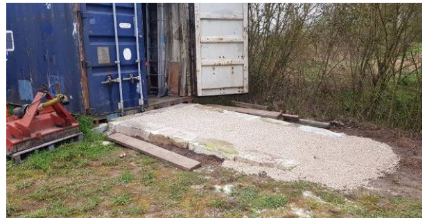
Exemple de travaux réalisés : rampe d'accès au container
